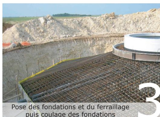
3 Pose des fondations et du ferrailage puis coulage des fondations
